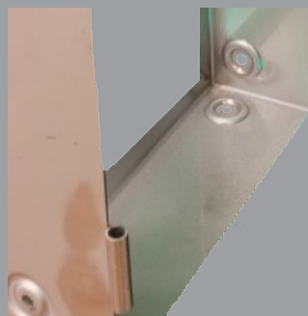
Joint d'étanchéité contre la bride du MagnaFrame II
